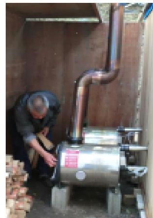
左は、まき風呂の写真です。浴槽はステンレス製で、2基設置されています。
